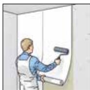
**3.** Bahn lotrecht und auf Stoß mit Tapezierbürste oder Tapetenandrückwalze blasenfrei verarbeiten. Kleisterflecken von Oberfläche entfernen. Nicht überlappend verkleben.
