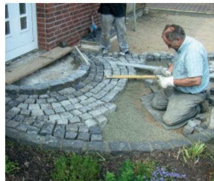
Verlegen von Kleinpflaster in PCI Pavifix DM.
