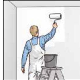
Encoller grassement et uniformément le support sur une largeur d'un (1) lé avec le système de collage ERFURT-KlimaTec en utilisant un rouleau à longs poils.
