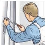
**6.** Dans les coins et sur les arêtes, découper le lé et tapisser le lé suivant bord à bord à joints vifs.
