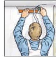
**5.** Enlever les excédents des plafonds, plinthes, fenêtres, etc. avec un cutter et une spatule de tapisier.
