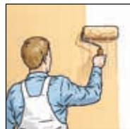
**7.** Après le séchage, recouvrir l'ingrain avec une peinture en phase aqueuse de qualité supérieure en conformité avec DIN EN 13300.
