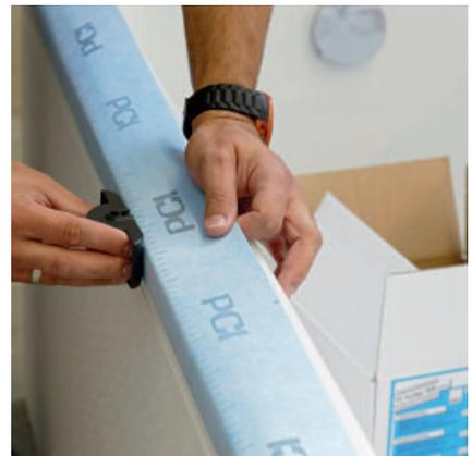
PCI Pecitape WDB mit dem Anpressroller kräftig anrollen, so dass keine Falten entstehen.
