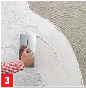
**Überspachteln alter Fliesenkleberreste:** Auch hier in einem ersten Arbeitsgang oberflächenbündig bis zum Ausgleich der Unebenheiten aufziehen. Nach dem Trocknen FEINER FLÄCHENSPACHTEL in gewünschter Schichtdicke auftragen.
