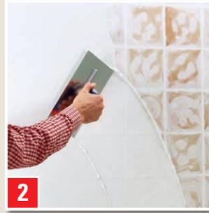
**Überspachteln eines alten Fliesenbelages:** Zunächst oberflächenbündig bis zur Füllung der Fugen aufziehen und trocknen lassen. Danach FEINER FLÄCHENSPACHTEL in gewünschter Schichtdicke auftragen.
