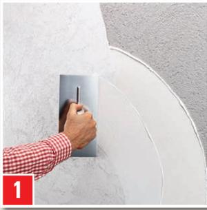
**Glätten eines rauen Wandputzes:** FEINER FLÄCHENSPACHTEL mit rostfreiem Stahlglätter dünn-schichtig aufkratzen. Anschließend frisch in frisch in gewünschter Schichtdicke auftragen und flächig abziehen. Vereinzelt Kellenschläge nach dem Trocknen abschleifen.
