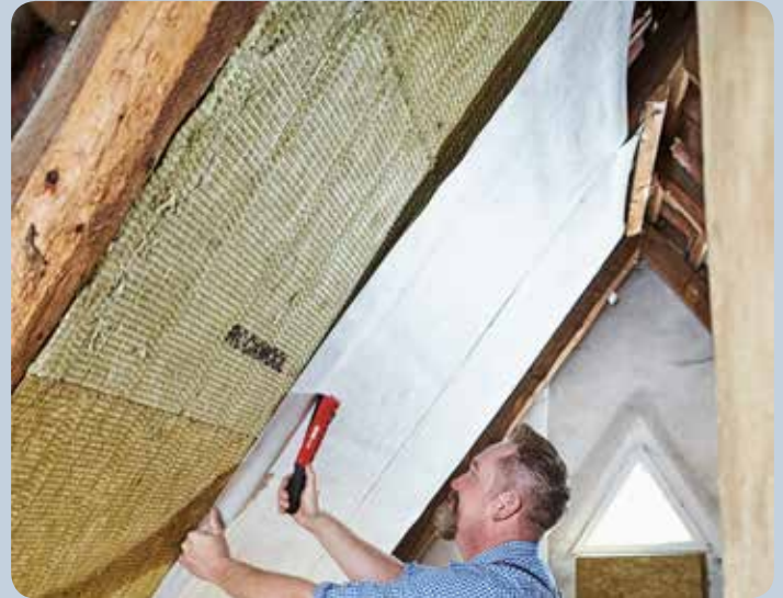
Folie beim Dachbodenausbau einfach befestigen.
