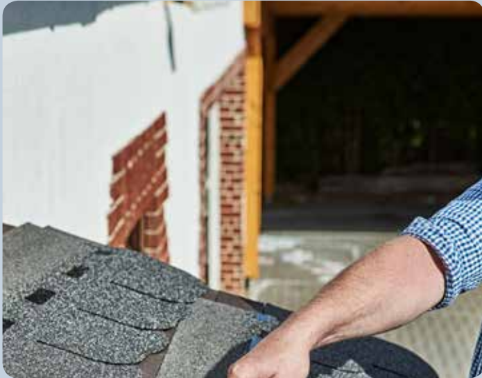
Schnelles Befestigen von Bitumenschindeln.
