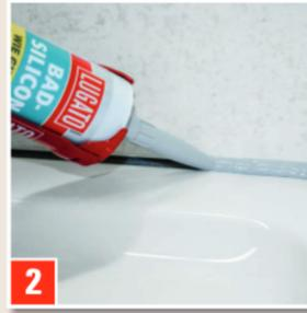
Mit Dichtstoff, im Bad z. B. mit BAD-SILICON, MARMOR + GRANIT-SILICON oder SCHIMMEL-STOPPER-SILICON, die Fuge füllen und mit FUGENGLÄTTER abziehen.
