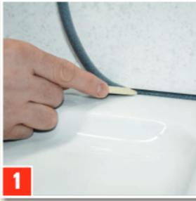
FUGEN-FÜLLPROFIL in der erforderlichen Länge abschneiden. Mit einem stumpfen Werkzeug, z. B. Pinselstiel, Eisstiel, Kunststofflöffel, komprimiert in die Fuge drücken. Oberfläche des Profils nicht beschädigen. Kein spitzes Werkzeug verwenden.
