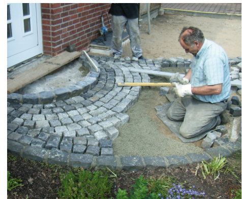
Verlegen von Kleinpflaster in PCI Pavifix DM.
