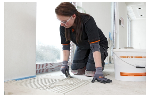
Mit PCI Carrament ® weiß können Naturwerksteinbeläge sicher im Mittelbettverfahren verlegt werden.
