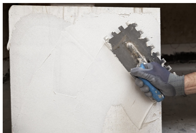
Zum hohlraumfreien Verlegen wird grundsätzlich eine Mörtelschicht auf die Plattenrückseite aufgetragen.
