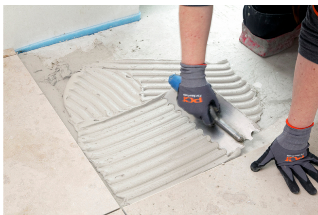
PCI Carrament® weiß ist ein plastisch-geschmeidiger Mittelbettmörtel und lässt sich leicht auftragen.
