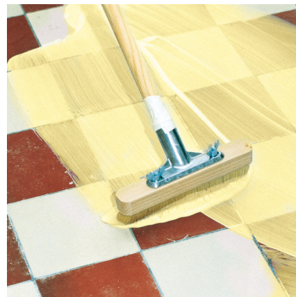
Grundierung auf dem Untergrund im "Kreuzgang" vollflächig verteilen.
