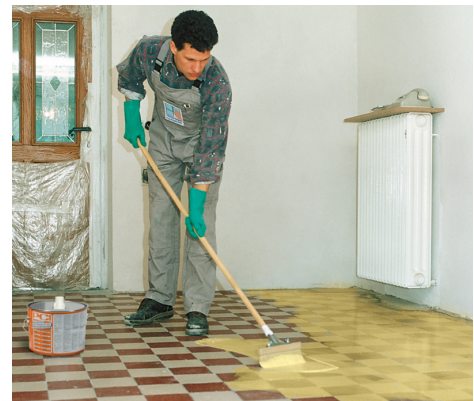
PCI Gisogrund 303 ist die sichere Haftgrundierung zum Verlegen von Belägen auf keramischen Fliesen und Platten.
