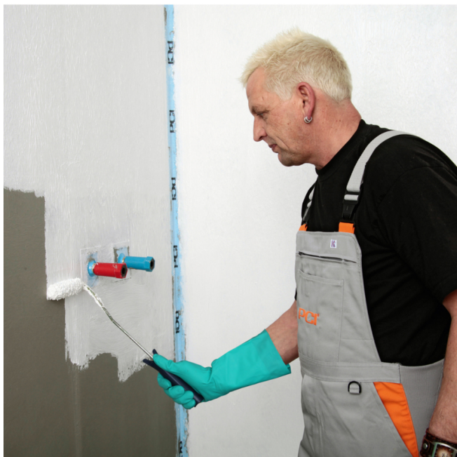
5. Après un temps de séchage d'env. 1 heure, appliquer la deuxième couche de PCI Lastogum.
