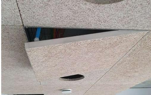
Bild: Einbaubeispiel in einer HWL-Decke
