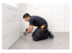
Elastisches Schließen von Boden-Wand-Fugen mit PCI Nanosil.
