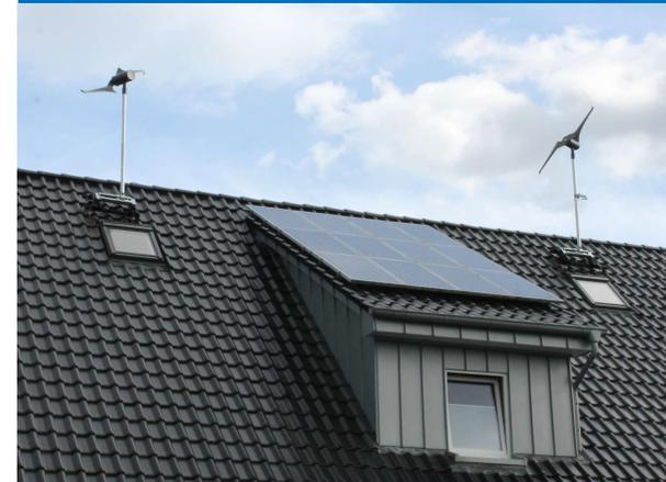
Entkoppelte Aufdachmontage auf Solarschiene (vgl. S. 24)
