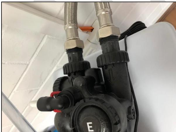
Anschließend mit dem Anschlussstück BSPT 1" des Steuerkopfs und mit den Anschlüssen des Hauswassernetzes bzw. Montageblockes verschrauben
