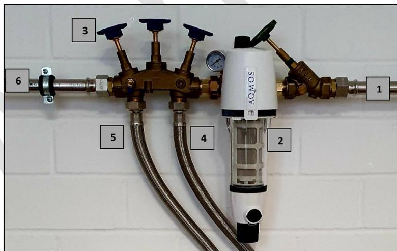
Das folgende Bild zeigt wie ein Wasserenthärter oder Nitratfilter zusammen mit dem Montageblock an das Hauswassernetz angeschlossen wird. (Fließrichtung von rechts nach links)
