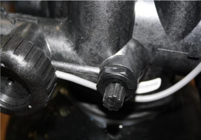
Verschneide Ventil am Steuerkopf zum Verschneiden der Restwasser Härte.
