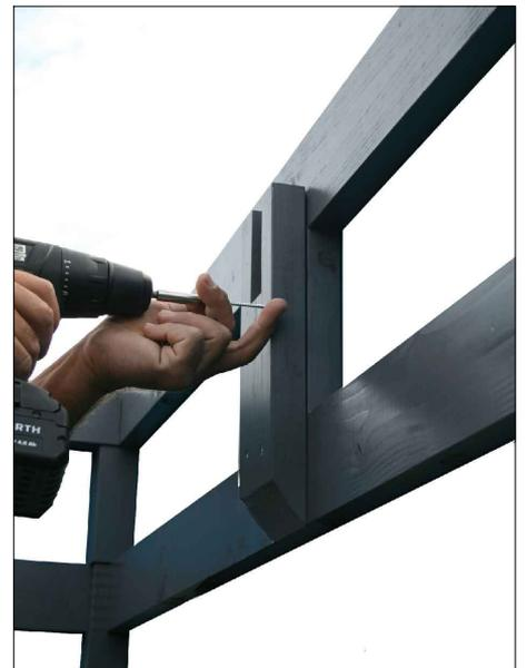
Après le pré-perçage, vissez les 4 supports de pannes avec 4x C105-0060 de l'intérieur sur les poteau intermédiaires.
