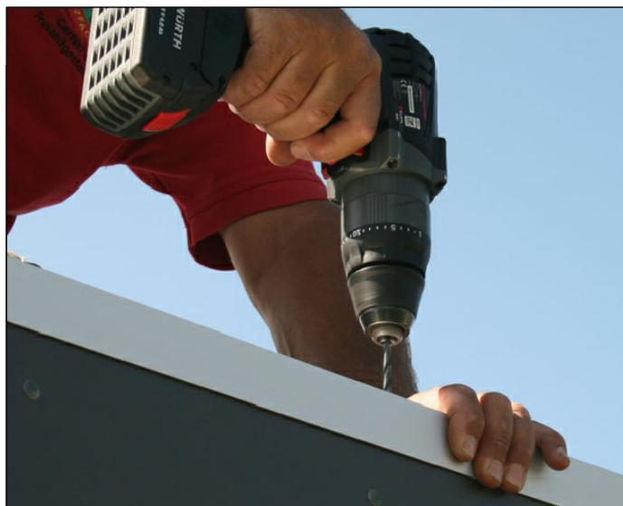
Après pré-perçage, vissez les rails en aluminium (A100-220) avec 6 vis 104-0030 sur la panne sablière au bord du toit. Laissez déborder les rails en alu de 2 cm sur la longueur.
