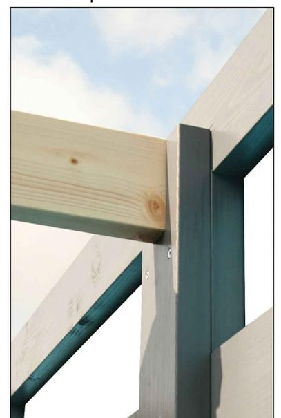
Posez les deux pannes dans les découpes des supports et vissez les pannes après pré-perçage de l'intérieur à travers les supports de pannes avec chaque foie une vis C105-0080.
