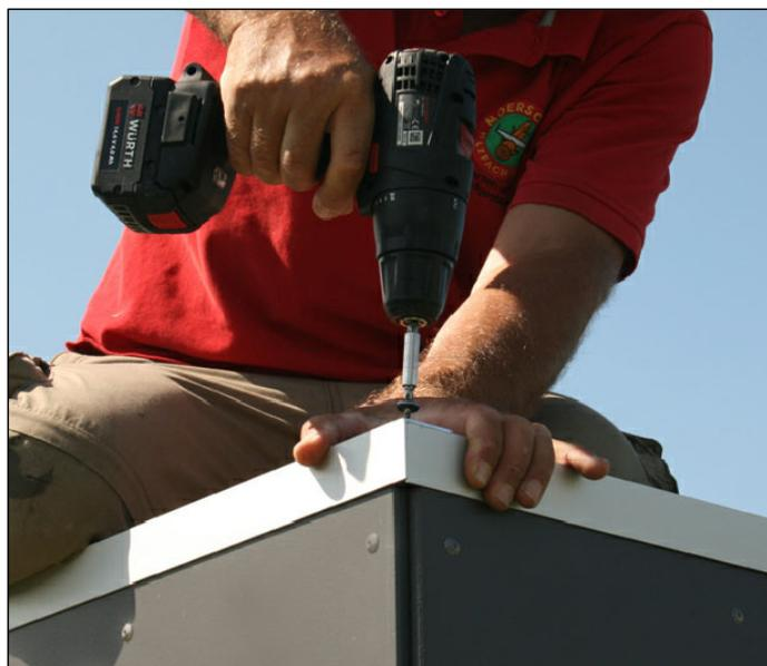
Dans les coins, posez les rails l'un sur l'autre et assemblez-les avec une seule vis.
