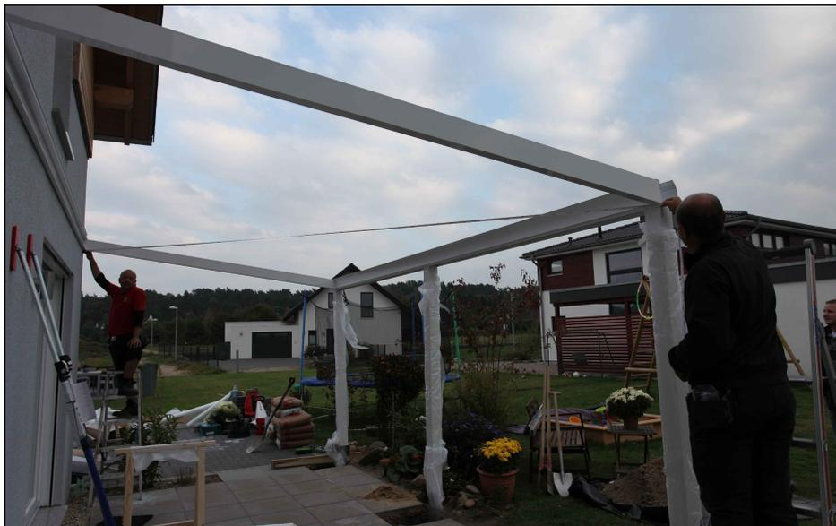
Alignez la construction en utilisant un ruban placé sur la diagonale.
