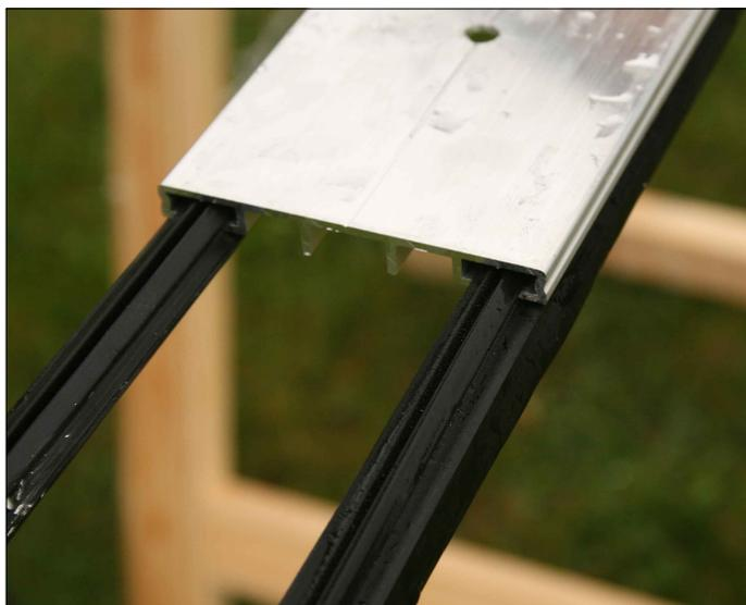
Posez le caoutchouc d'étanchéité dans les profilés aluminium.
