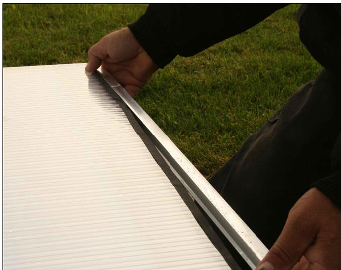
Poussez le profilé de finition sur les bords avant et arrière des plaques au-dessus de la bande d'étanchéité.
