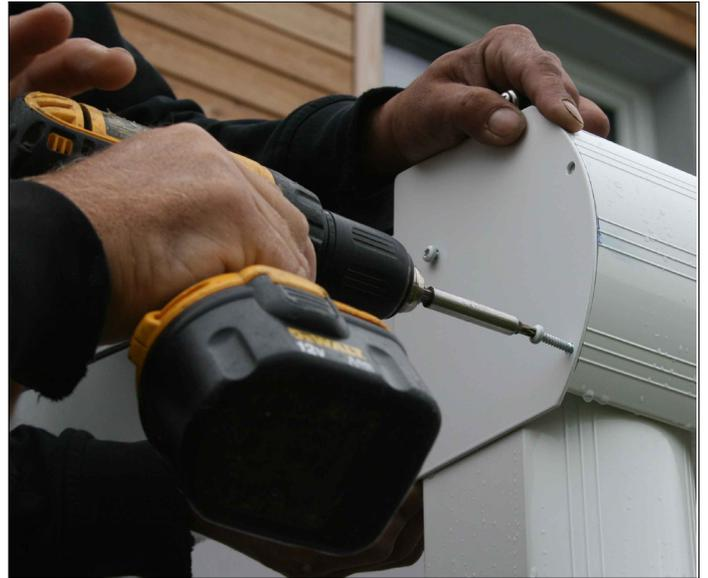
Avant de procéder au vissage, appliquez de la silicone dans les canaux de vissage des capouchons chaches. Fixez ensuite les capouchons sur la panne pour gouttière en utilisant respectivement 4 vis à tête hexagonale (C101-025).
