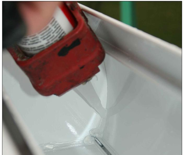
Après avoir placé les capouchons chaches, étanchéifiez-les également de l'intérieur à l'aide de silicone.
