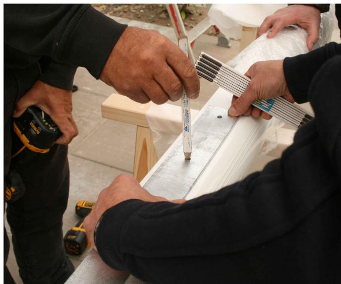
Tracez les trous de vissage filetés et pré-perçés des différentes ancrs pour poteau sur les poteaux respectifs. Pré-percez en utilisant un foret à métaux 9 mm, puis poussez les ancrs dans les poteaux correspondants. Tracez, percez, puis vissez ancre pour ancre, les trous d'alésage des différentes ancrs pouvant varier !
