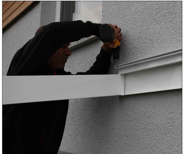
Pré-percez les trous de vissage à l'aide d'un foret à métaux 4 mm, puis vissez les chevrons sur les deux pannes en utilisant pour chacune une vis à tôle à tête hexagonale (C101-025).
