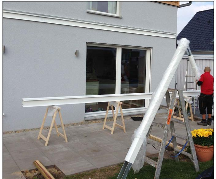
Préparez au montage la panne pour gouttière et les poteaux avec leurs ancres.
