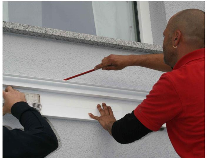
Pré-percez les trous dans la panne pour mur (à une distance d'environ 40 cm) en utilisant un foret à métaux. Maintenez la panne sur le mur de la maison, puis alignez-la à l'aide du niveau à bulle. Tracez ensuite les trous d'alésage, puis percez-les en vous conformant aux indications du fabricant de chevilles. Montez la panne pour mur en utilisant le matériel de fixation adéquat (tirants d'ancrage M12, par ex.).
