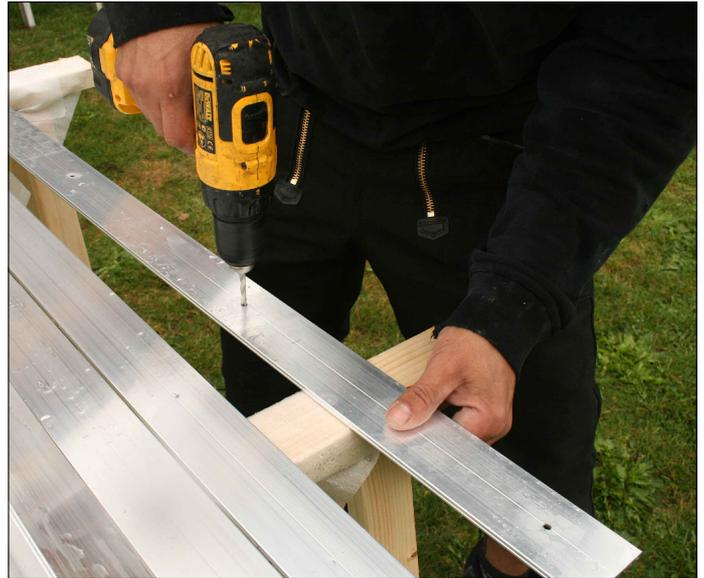
Posez le caoutchouc d'étanchéité dans les profilés aluminium, puis pré-percez ces derniers à une distance uniforme, en utilisant un foret à métaux 5 mm. Divisez le nombre des vis (voir plan de position) par celui des chevrons afin d'obtenir le nombre total des vis à répartir par profilé aluminium.
