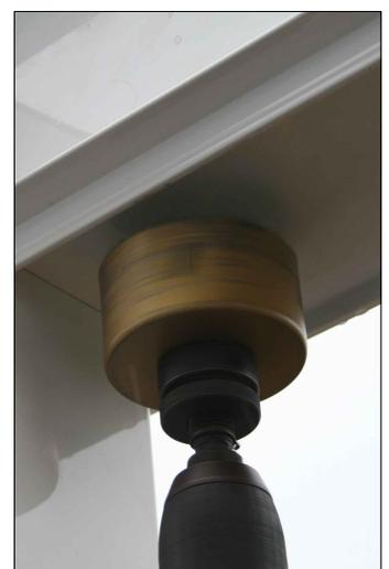
En utilisant un trépan (diamètre 68-70 mm), percez alors le raccordement pour la chute, que vous pourrez monter aussi bien à côté du poteau que dans ce dernier, sans oublier de tenir compte du décalage de la panne pour gouttière (voir plan de détail) ainsi que de la distance des supports à clip par rapport à la chute allant vers le poteau ! (environ 2 cm)
