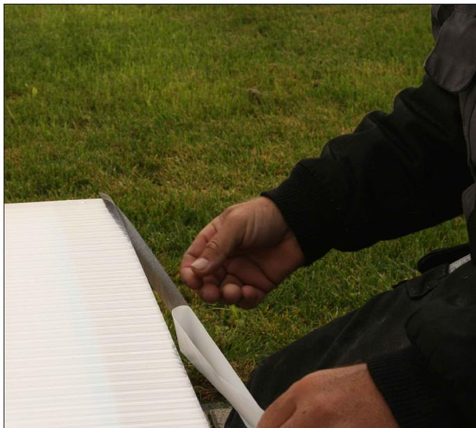
Retirez le film protecteur des plaques alvéolaires (attention à ne pas confondre face supérieure et inférieure !), puis posez-y une bande d'étanchéité aux niveaux avant et arrière.
