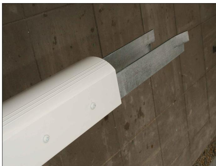
Vissez les ancrs à l'aide des vis d'assemblage fileté (C115-020).
