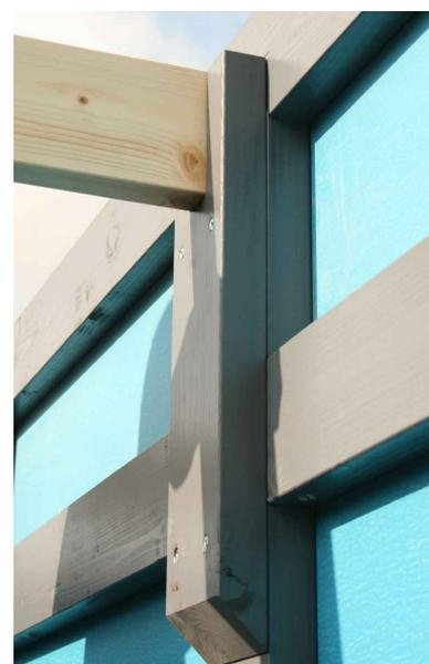
Posez le(s) panne(s) dans les découpes des supports et vissez le(s) panne(s) après pré-perçage de l'intérieur à travers les supports de panne avec chaque fois une vis C105-0080.
