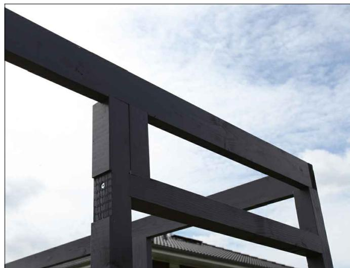
Placez la traverse de bois horizontale du linteau dans les découpes prévues à cet effet, en veillant à affleurer les bords extérieurs des éléments de la construction. Pré-percez et fixez de chaque côté avec 2 vis C105-0100 par l'extérieur en traversant les poteaux. Restez à 4 cm du bord extérieur en vissant.
