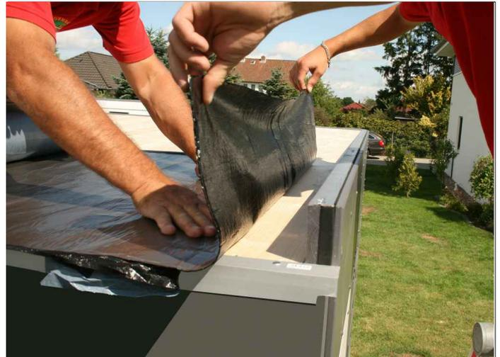
Posez maintenant le revêtement autocollant. Le revêtement doit être posé transversalement par rapport à la pente du toit. Déroulez environ 100 cm de revêtement et laissez pour l'instant le film de protection sur le revêtement afin de pouvoir ajuster exactement le revêtement. Ce n'est qu'après avoir ajusté exactement le revêtement qu'il faut retirer le film de protection sur 10 cm et fixer le revêtement avec précision.
