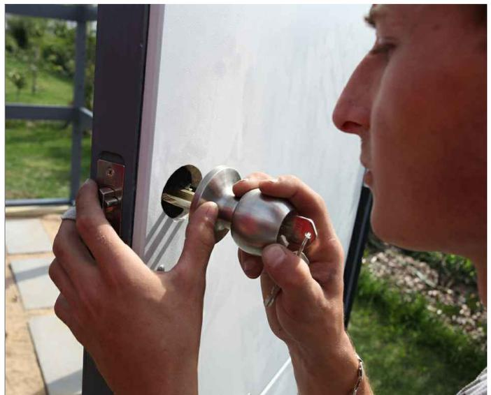
Glissez maintenant la poignée extérieure de la porte avec la tige d'entraînement dans le trou percé à cet effet à l'extérieur de la porte. Le trou de serrure est orienté vers le bas !
