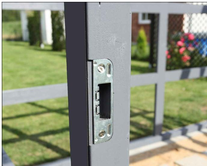
Positionnez ensuite la gâche de la serrure dans la découpe du poteau de porte à gauche et vissez-la avec 2 des vis ci-jointes après pré-perçage.
