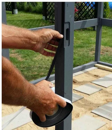
Collez sur le support de construction la bande d'étanchéité EPDM A109 (largeur de 9mm) et A111 (largeur de 30 mm). Pour les endroits où les plaques de façades se rejoignent, utilisez la bande A111, pour le haut et le bas du support de construction, posez la bande A109. La bande doit être collée bord à bord pour éviter les infiltrations d'eau. Collez la bande d'étanchéité à parts égales sur les angles des coins. Restez à 0,5 cm du bord en haut !
