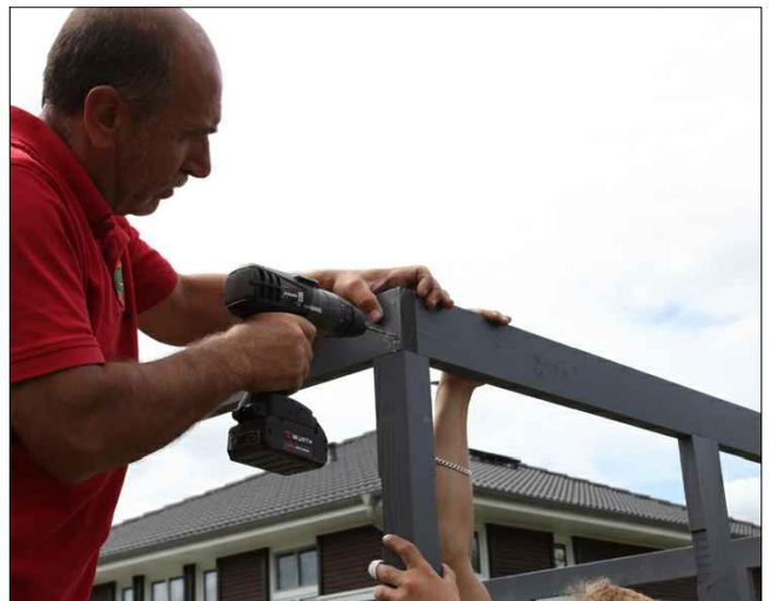
Maintenant vissez ensemble les coins des pannes sablières se trouvant à la même hauteur avec 2 vis C105-0080 après pré-perçage. Écartez les vis à 1,5 cm du bord extérieur.
