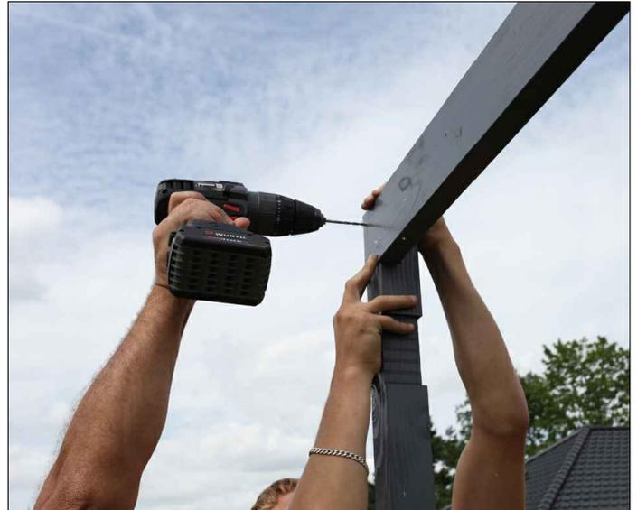
Positionnez la panne sablière à la découpe à l'arrière du support de la construction, pré-percez et vissez la panne sablière avec 2 vis C105-0050 au poteau d'angle, en respectant une distance de 4 cm par rapport au bord extérieur du poteau.
