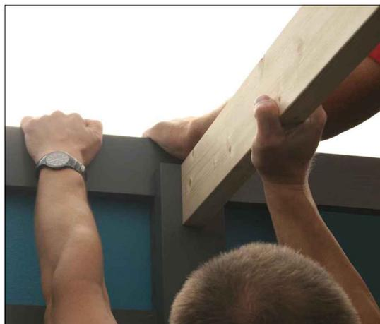
Afin de déterminer avec précision la hauteur de pose de(s) panne(s) et des supports de panne(s), positionnez une volige dans le sens de la hauteur, depuis le support de voliges à l'avant jusqu'à la panne sablière arrière. Marquez ensuite le bord supérieur de la panne afin de déterminer l'emplacement exact des supports de pannes.
