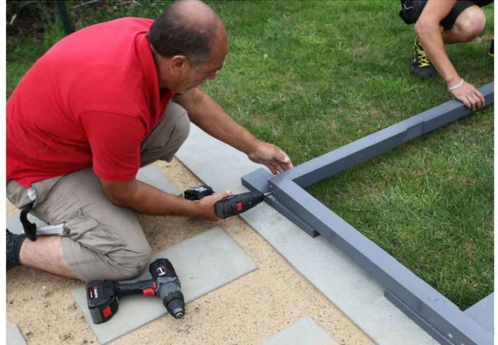
Vissez ensuite les deux poteaux d'angle au niveau de la porte également avec 2 vis C105-0100 en traversant par le bas les madriers de seuil à l'endroit des découpes prévues. Veuillez veiller à la bonne orientation des poteaux par rapport aux ferrures des portes !
