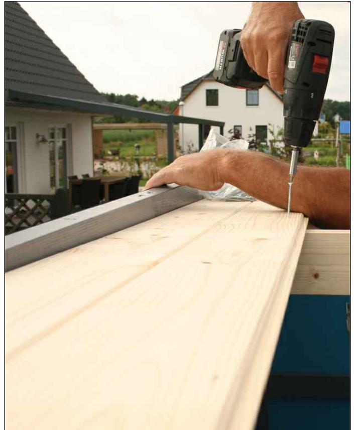
Après avoir pré-percé, vissez les voliges profilées avec chaque fois 2 vis C105-0040 devant sur la traverse derrière la panne sablière, sur la (les) panne(s) et sur la panne sablière à l'arrière. Le voligeage doit dépasser à l'arrière du toit afin de pouvoir fixer éventuellement une gouttière (en option).
