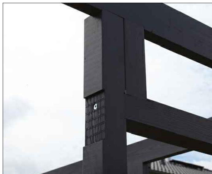
Positionnez maintenant la pièce de bois courte à la verticale, à gauche au-dessus du linteau, pré-percez et fixez-la de l'intérieur au poteau avec 2 vis C105-0100.
