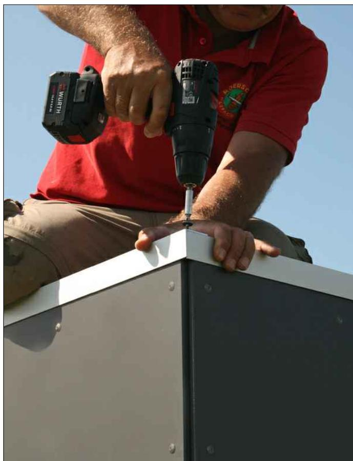
Dans les coins, posez les rails l'un sur l'autre et assemblez-les avec une seule vis.
