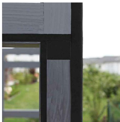
La bande d'étanchéité doit être collée bord à bord pour éviter les infiltrations d'eau !
