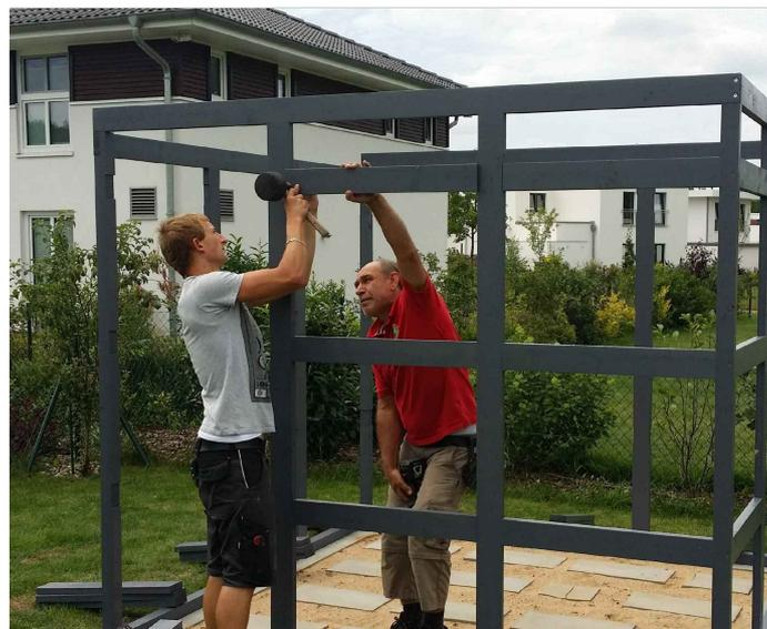
Fixez les madriers intermédiaires restants en suivant la même procédure. Commencez par les trois madriers intermédiaires au centre de chaque côté et vissez-les après pré-perçage en traversant les poteaux avec des vis C105-0150. Respectez une distance de 1,5 cm par rapport à l'extérieur de la construction.
