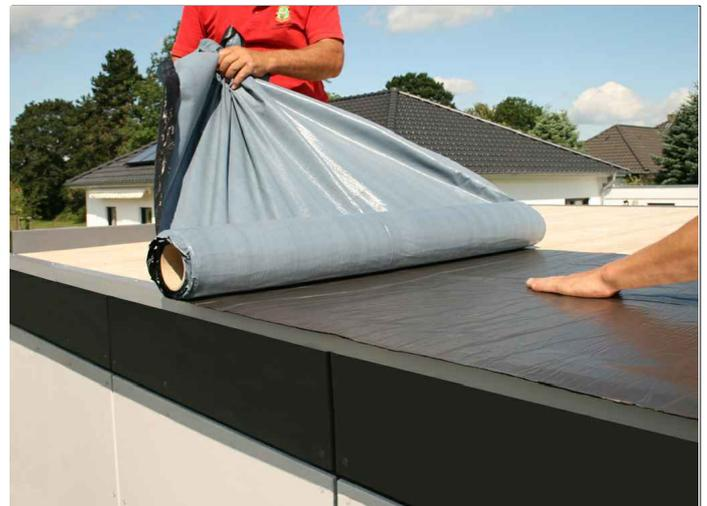
Laissez dépasser du bord assez de revêtement pour garantir une bonne finition de bordure. Avec avoir entièrement collé la première bande, posez la deuxième bande en recouvrant la première sur 20 cm. Vous garantirez un bon collage en passant un rouleau sur la zone de recouvrement.
