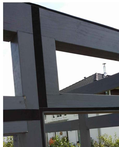
Commencez par coller la bande d'étanchéité (A109) en bas à 2cm du bord. De manière générale, collez toujours les joints bord à bord afin d'éviter les infiltrations d'humidité !
