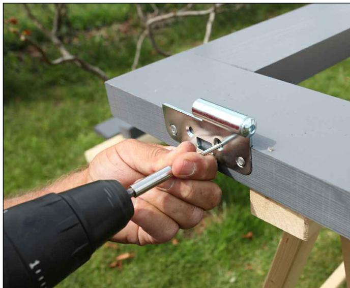
Positionnez l'ouvrant du bon côté et fixez maintenant les trois paumelles de la porte dans les découpes prévues à cet effet avec 4 des vis ci-jointes après pré-perçage.
