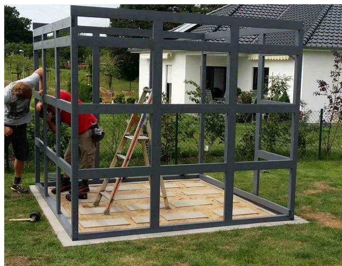
Vissez les madriers intermédiaires des bords en traversant les poteaux après pré-perçage avec des vis C105-0100. Vissez les vis intérieures en traversant les madriers intermédiaires en biais par le bas dans les poteaux intermédiaires respectifs.
