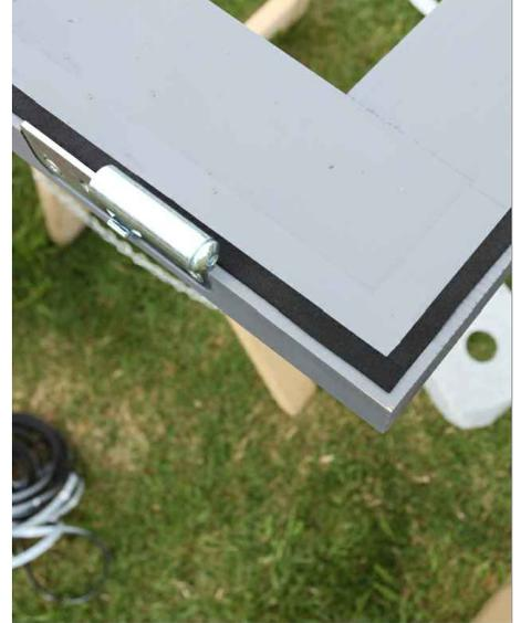
Collez maintenant le joint d'étanchéité de 9 mm (A109) sur le bord extérieur du côté externe de la porte en respectant un écartement de 3 mm par rapport au bord externe. À la jonction des plaques au milieu veuillez utiliser le joint d'étanchéité A111.
