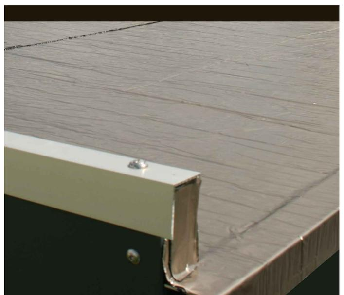
Après collage et roulage des bandes de revêtement, ajustez les bords en les coupant avec un cutter.
