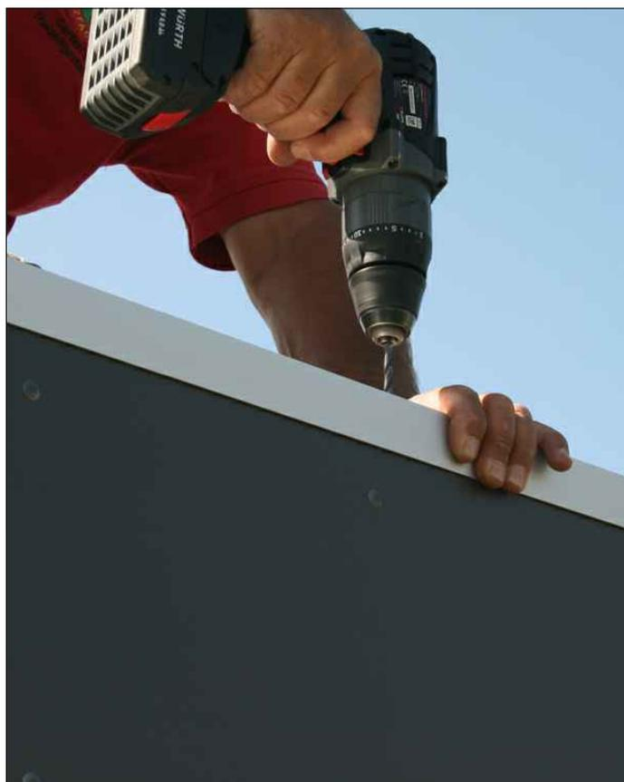
Après pré-perçage, vissez les rails en aluminium (A100-220) avec 6 vis 104-0030 sur la panne sablière au bord du toit. Laissez déborder les rails en alu de 2 cm sur la longueur.
