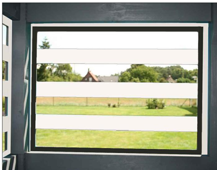
Collez maintenant la bande EPDM A109 à l'intérieur sur les côtés des plaques de fenêtres de la façade pour assurer l'étanchéité. (Commencez directement à ras des ouvertures). Collez ensuite les bandes de joint manquantes en haut et en bas en les ajustant bien contre les joints latéraux.
