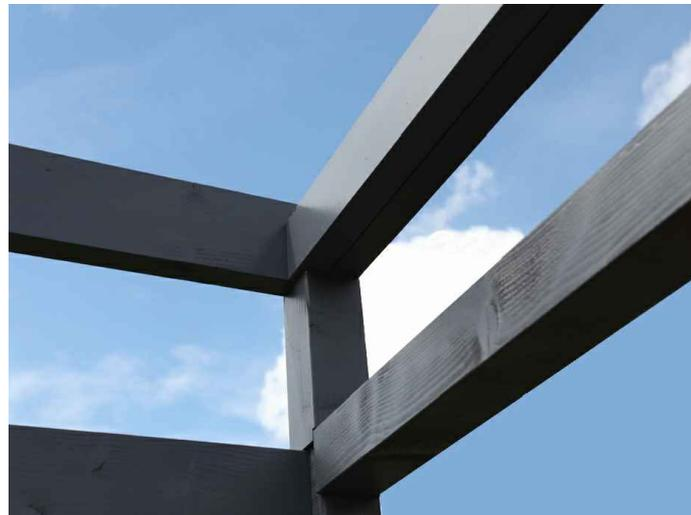
Placez maintenant la traverse de support des voliges sur le poteau d'angle de la façade, pré-percez et vissez-la de l'intérieur contre la panne sablière avec 5 vis C105-0050. Laissez aux extrémités un écart d'env. 5 cm.
