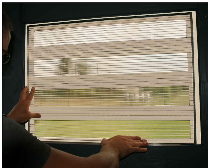
Placez maintenant les doubles plaques alvéolaires C200-250 dans les cadres correspondants, contre la bande d'étanchéité et mesurez la longueur des baguettes de finition afin de couper celles-ci à la bonne longueur.
