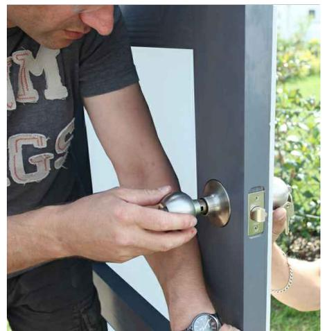
Maintenant, positionnez la pièce métallique de couleur laiton exactement au milieu de la découpe sur la face interne de la porte pour la fixer avec la partie externe de la serrure à l'aide des vis jointes. Emboîtez maintenant le support en acier inoxydable sur la pièce métallique et enflez la poignée tournante intérieure. Enfoncez pour cela le ressort à l'aide de la petite tige métallique pour que la poignée puisse s'enclencher.
