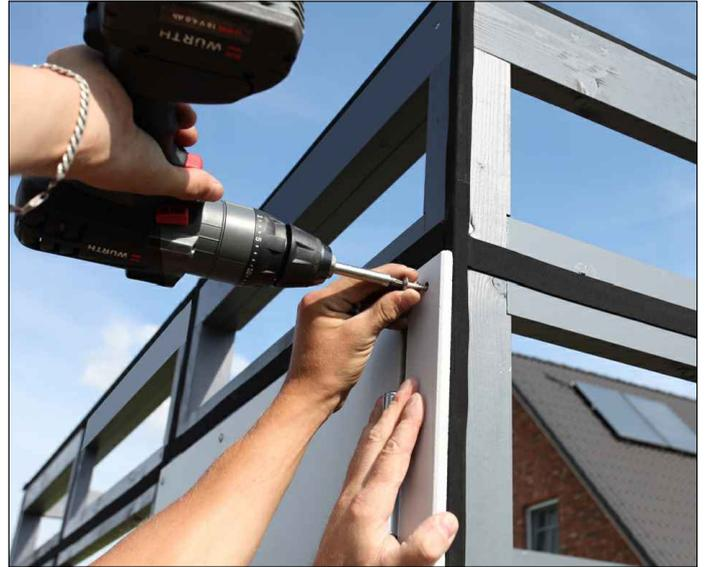
Pour visser les plaques, commencez par les plaques minces à droite de la porte. Vérifiez la rectitude avec le niveau à bulle et laissez un espace de 1 cm entre les plaques !
