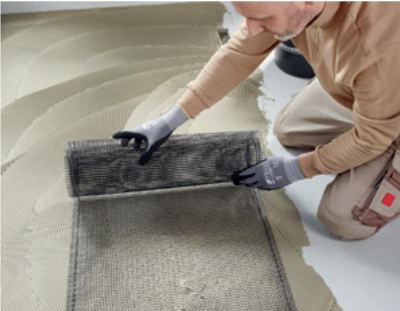
Abbildung 10: eThermoHeld • FLIESE • Heizgitters eingelegt und abrollen, glattgestrichen. Befestigung der Zuleitungen mit Klebeband. Im Randbereich ohne Gitter gröbere Zahnung verwenden (ca. 2 – 4 mm größer).
