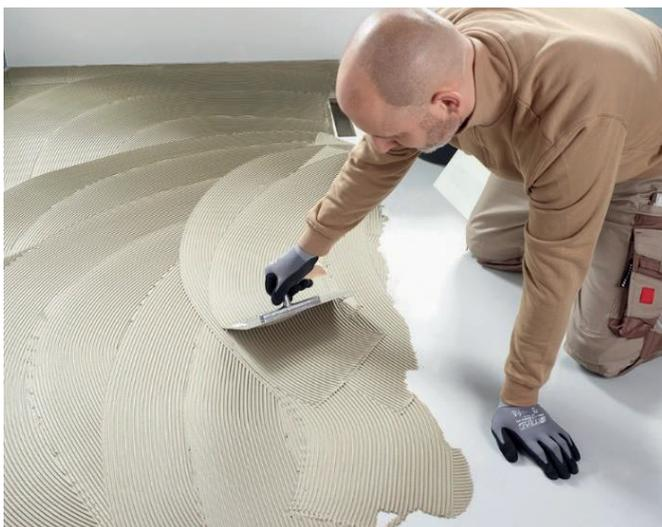
Abbildung 9: Fliesenkleber auftragen (6 mm Zahnung)
