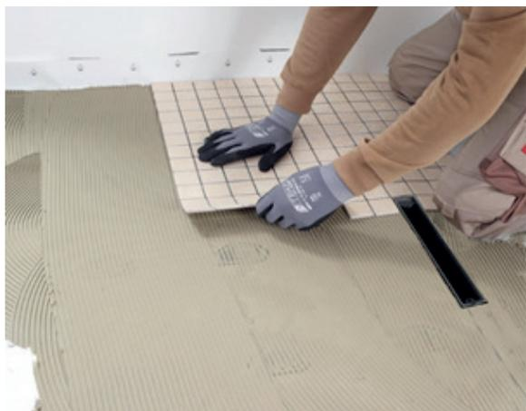
Abbildung 13: Fliesenkleber auftragen und Fliesen legen
