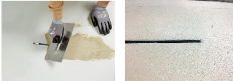
Abbildung 7: Einbetten des Bodenfühlers ohne (links) oder mit Leerrohr (rechts) in Spachtelmasse
