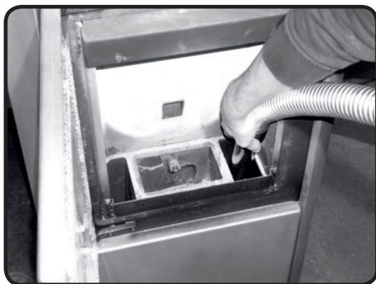
Abb. 14g: Reinigung untere Brennkammer
