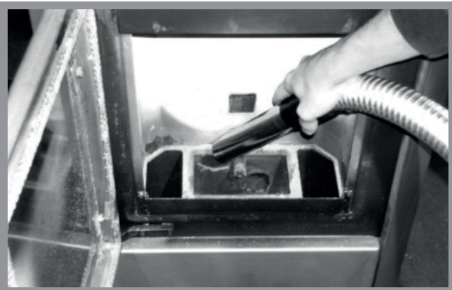
Abb. 12d: Reinigung der Topfhalterung
