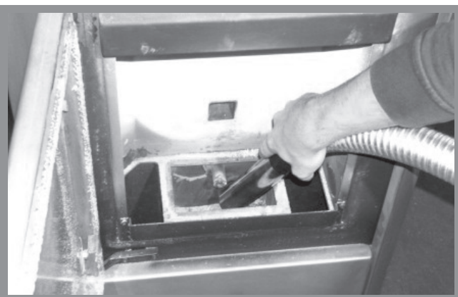
Abb. 12f: Reinigung Brennraumbehälter
