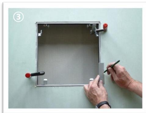
Rahmen ausrichten (Recht-Winkligkeit prüfen), festspannen und Bohrungen mit Schablone anzeichnen, Bohrabstand  $\leq 200$  mm. Bei luftdichter Ausführung Bohrabstand  $\leq 100$  mm.
