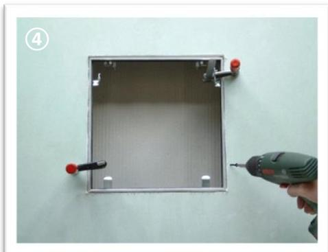
Rahmen verschrauben und beiliegende Schutzkappen rückseitig aufstecken.
