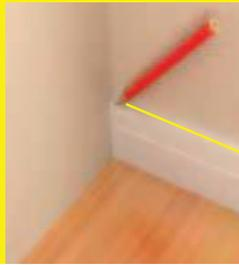
Setzen Sie die nächste Bodenleiste stumpf anschließend an und markieren Sie mit Bleistift die Schnittlinie für den I
