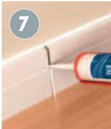
Bestreichen Sie die nächste Bodenleiste einschließlich der Enden mit Kleber, um sie dann stumpf anschließend auf gleiche Weise zu verkleben. Sehen Sie an den einzelnen Übergängen eine  $\pm 2$  mm breite und mit Kleber aufgefüllte Dehnfuge vor. Streichen Sie überständigen Kleber mit dem Finger oder einer Spachtel glatt.
