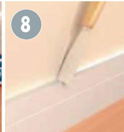
Ziehen Sie überschüssigen Kleber an der Oberseite mit Hilfe einer Spachtel ab.
