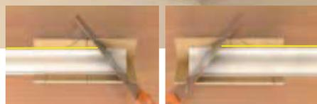
Legen Sie die Deckenleiste ordnungsgemäß ausgerichtet in die Gehrungslade ein und führen Sie den Schnitt - wohlgemerkt am richtigen Ende aus.
