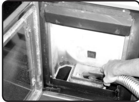
2. Entnehmen Sie dann den Brenntopf. Überprüfen Sie die Luftöffnungen am Boden des Brenntopfes. Vergewissern Sie sich, dass alle Luftöffnungen weder verstopft noch zugesetzt sind. Saugen Sie den Brenntopf gründlich ab (siehe Abb. 14b). Entfernen Sie hartnäckige Verkrustungen und Blockaden, wenn nötig, mit einem geeigneten Werkzeug (siehe Abb. 14c).
