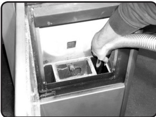
Abb. 14g: Reinigung untere Brennkammer
