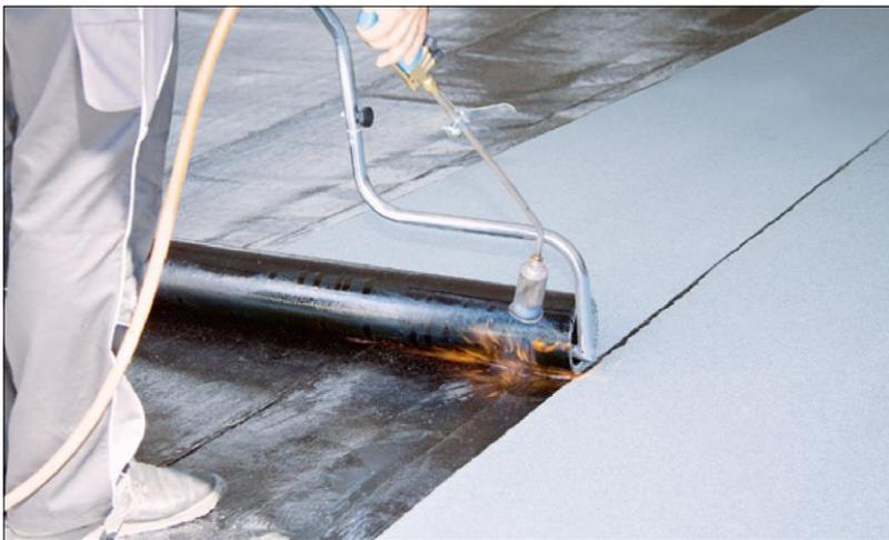
*Bild 6: Verarbeitung im Schweißverfahren mit Rollenführungsbügel*
