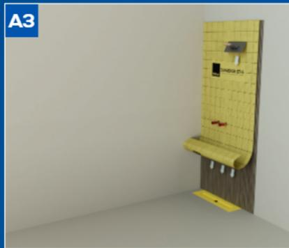
Bahn ausrichten, anbringen und faltenfrei und ohne Luftblasen alle Flächen (Wand und Boden) mit der DURABASE ET-S Abdichtbahn verlegen (Stoßverlegung)
