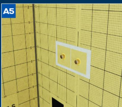
Alle benötigten Rohrdurchführungen mit den DURABASE ET-S Dichtmanschetten und dem CLASSIC FLEX Klebedichtstoff befestigen.
