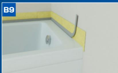
Mittels Wasserwaage oder Laser die Oberkante der Wanne an der Wand anzeichnen.
