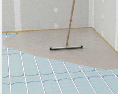
Ausgießen der Therm25-Elemente mit fermacell™ Ansetzbinder
