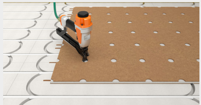
Montage der Abdeckplatte und mechanische Befestigung mittels Schrauben oder Klammern unter Verwendung der Schablone.
