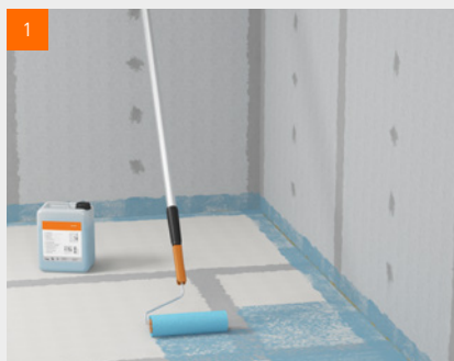
fermacell™ Tiefengrund im angrenzenden Wandbereich und Bodenbereich per Rolle auftragen
