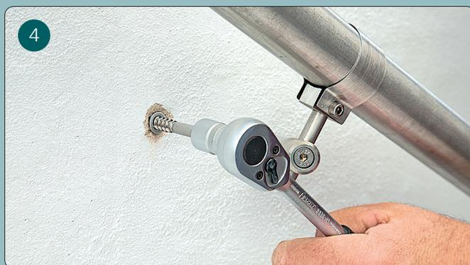
4 Vissez la vis à double filetage fournie. Utilisez soit un écrou M8 soit un embout Torx T25.
