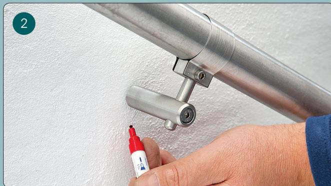
2 Montez les supports de main courante à intervalles réguliers entre 80 et 120 cm (insérer simplement sur le tube rond) et marquer les trous de perçage.
