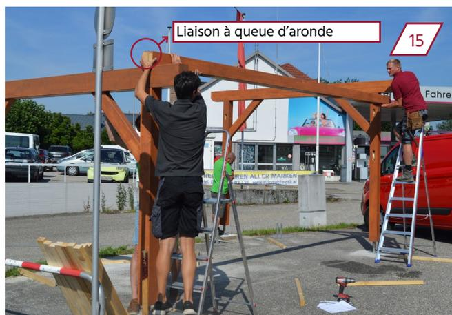
Mettre en place le poteau latéral entre le mur arrière et le mur avant. Pousser la liaison à queue d'aronde sur le côté plus bas.
