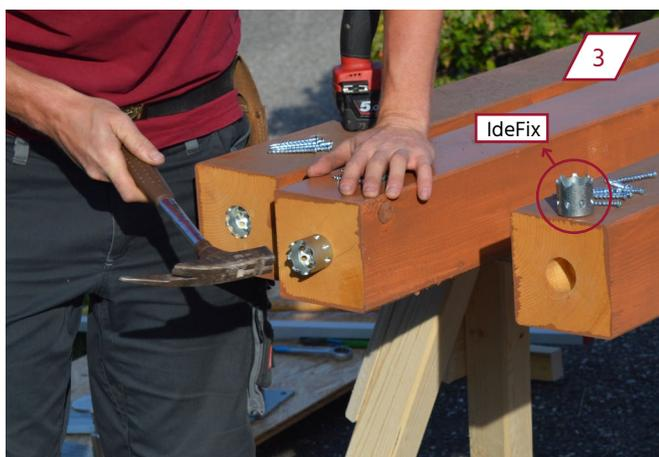
Rassembler les piliers à l'aide du schéma des murs. Mettre les IdeFix dans l'évidement de fraisage prévu à cette fin et les faire entrer dans la poutre à l'aide d'un marteau. L'IdeFix doit être au ras du bord du bois.
