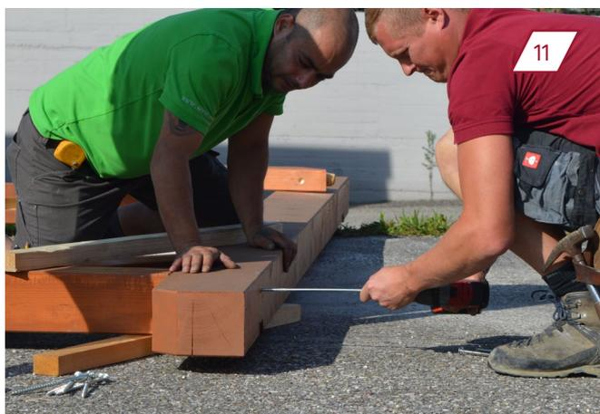
Visser les piliers et la poutre transversale d'en bas et d'en haut (respecter le schéma de vissage et utiliser les bonnes vis).
