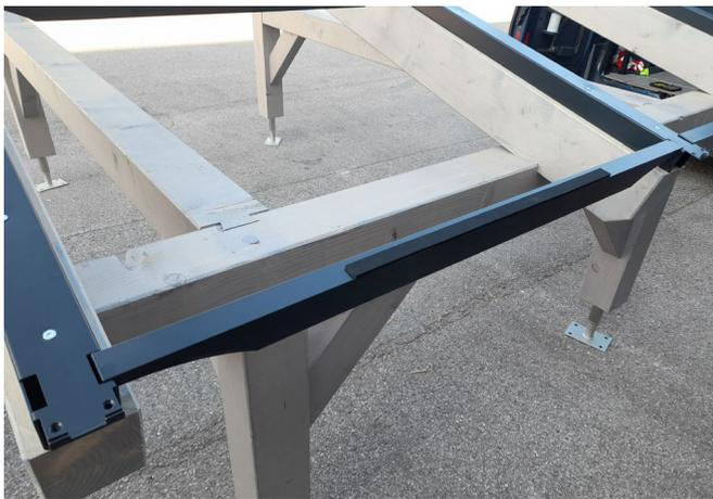
Placez les barres transversales dans l'évidement sur les bords inférieur et supérieur de la cale.
