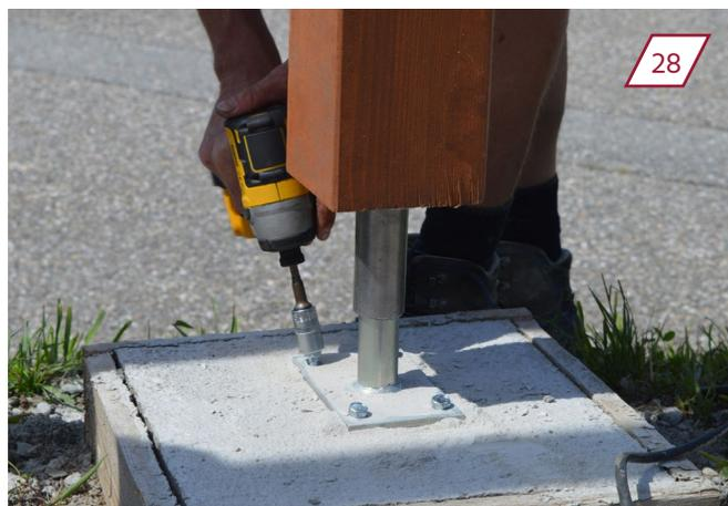
Visser les vis à béton à l'aide d'une clé à chocs ou d'une clé plate.
