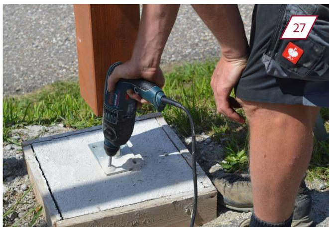
Visser le pied d'appui aux fondations en béton.
