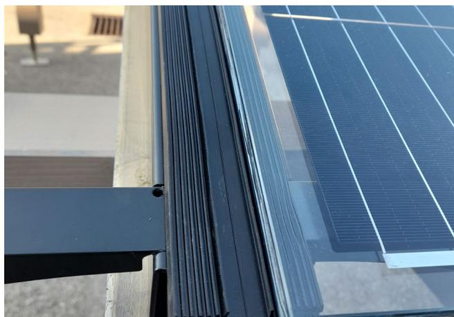
Le module est placé au milieu et couvre un de chaque côté rainuré du support en caoutchouc.
