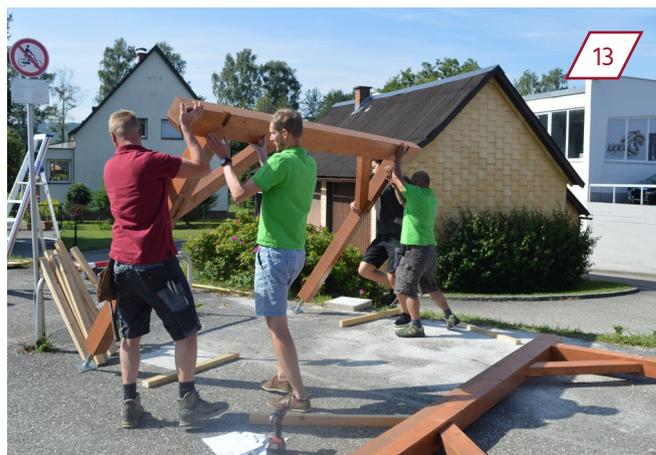
Ériger le mur arrière. Placer les pieds d'appui sur les fondations en béton.
