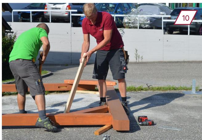
Intégrer les lanières (respecter le schéma des murs pour choisir les bonnes lanières) entre le pilier et la poutre transversale à l'aide des barres et de la massette. Procéder de la même manière sur le côté opposé.
