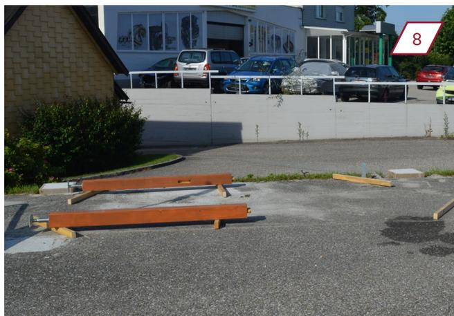
Poser deux piliers du mur arrière sur les lattes parallèlement à la bonne distance entre eux. Dans l'idéal, les pieds d'appui des piliers devraient déjà se trouver à proximité des fondations par points.
