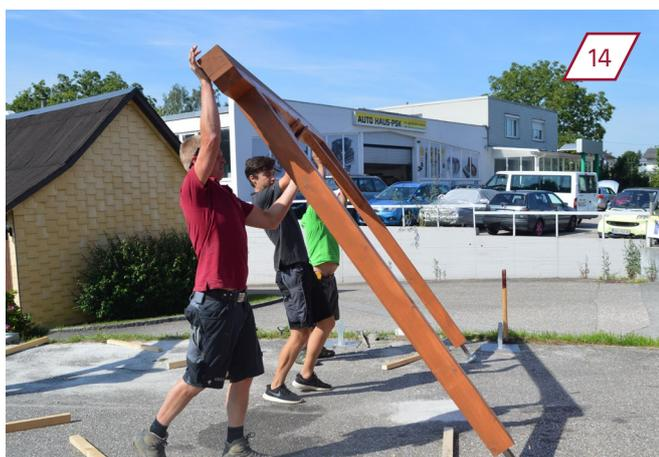
Ériger le mur avant. Placer de nouveau les pieds d'appui sur les fondations en béton.
