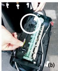
9. Stechen Sie mit Hilfe eines Schraubendrehers die vorgestanzte Aussparung an allen drei Steuerköpfen heraus (a). Verbinden Sie an Säule B und C die jeweiligen Enden der Kabel mit den passenden Steckverbindungen der Steuerköpfe. Führen Sie dazu die Verbindungskabel der Slave-Säulen B und C durch die ausgestanzten Aussparungen zu Master-Säule A (b). **Hinweis: Master-Säule A ist an dem bereits montierten Aufsteckrahmen zu erkennen.**
