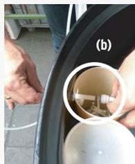
7. Montieren Sie sorgfältig die John-Guest-Anschlusswinkel mit Teflon- oder Dichtband an das Außengewinde des Steuerkopfes. **Hinweis: Das Außengewinde des Steuerkopfes fachgerecht ausschließlich mit Teflonband eindichten (Kunststoffgewinde)!** Längen Sie die Soleleitungen gemäß den Abständen der Säulen zum Solebehälter fachgerecht ab und verbinden Sie die Enden mit den Steuerköpfen (a) und den Anschlüssen der drei Ansaugsäulen im Solebehälter (b).
