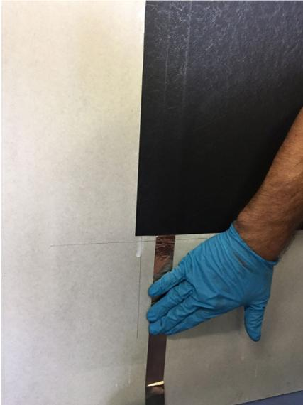
Abbildung 11: Ankleben der Elektroden, dazu weiße Schutzfolie auf der Rückseite der Kupferbänder abziehen
