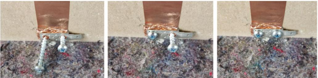
Abbildung 13: Anschrauben der Crimp-Kontakte, auf korrekte Auswahl der Schrauben für den jeweiligen Wandtyp achten! Bei Trockenbau auf Metallleisten müssen Isolierhülsen verwendet werden!
