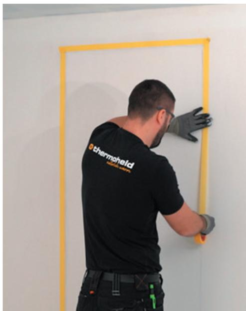
Abbildung 5: Anzeichnen des Umrisses der Heizfläche (links) und markieren mit Kreppband (rechts)
