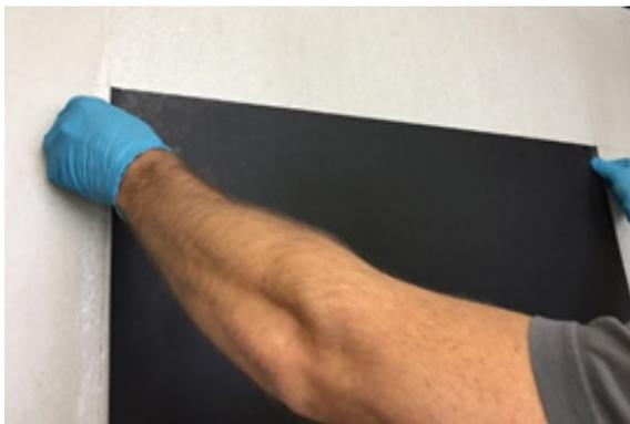
Abbildung 9: Anlegen des Heizvlieses an den angezeichneten Linien, auf die Orientierung der Elektroden bzw. der Anschlüsse achten!
