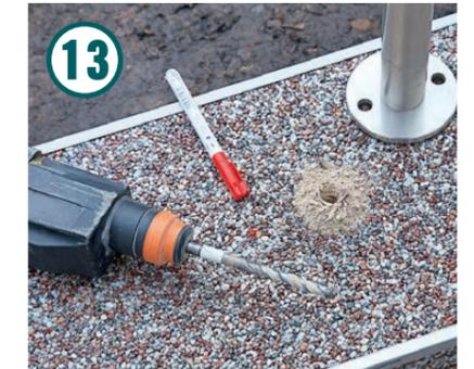
Alle Bohrlöcher durch die Montageplatte hindurch anzeichnen, Geländer abrücken und Löcher bohren.
