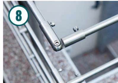
Für die Ecken sind Gelenkverbindungen im Set enthalten. Einfach aufstecken und mit einem Inbusschlüssel festziehen.
