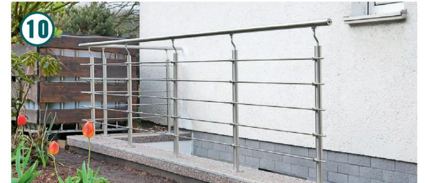
Sind alle Stäbe und Rohre verbunden, können Sie das Geländer ausrichten, ggf. die Befestigungen erneut lösen und die Stäbe und Rohre passend verschieben.
