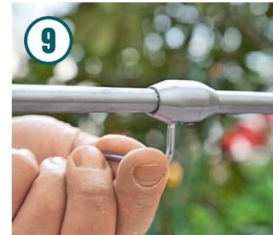
Zwischen Rundstäben und Rohren sollten Sie Verbinders in 10 mm bzw. 40 mm Durchmesser einsetzen.
