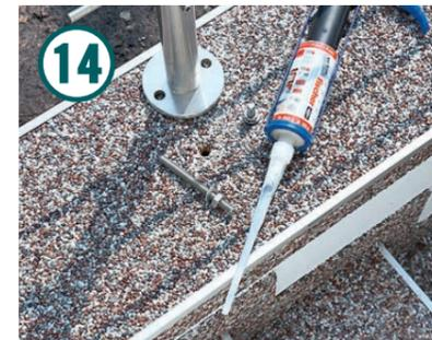
Verwenden Sie nur Schwerlastbefestigungsmittel oder Injektionsmörtel. Siebhülse ins saubere Bohrloch setzen, Mörtel einfüllen, ...
