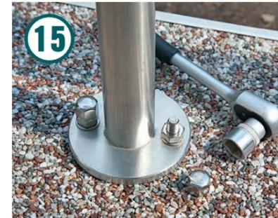
... Gewindestange drehend hineindrücken. Zur Befestigung empfehlen sich Hutmuttern.
