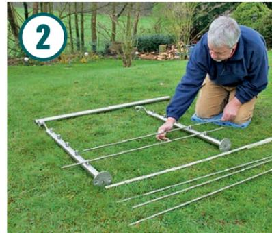
Die Rundstäbe (ø 10 mm) durch die Rundstabhalter an den Stützen schieben.
