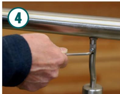
Stellen Sie ein Geländerteil an ungefährender Position auf und befestigen Sie den Handlauf (ø 40 mm) an den Stützen.
