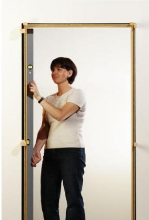
5. Band- und Verriegelungspunkte müssen druckfest hinterfütert werden. Der Spalt zwischen Bandaufnahmeelementen bzw. Schließblech-halteplatten und Mauerwerk muss so aufgefüllt werden, dass keine Auslenkung möglich ist. Als Materialien eignen sich z.B. Hartholz, Hartfaserplatten, Multiplexstreifen o. ä.. Verkleben Sie das Auffütterungsmaterial untereinander und zu Mauerwerk bzw. Zarge mit PU-Kleber oder Silikon.
