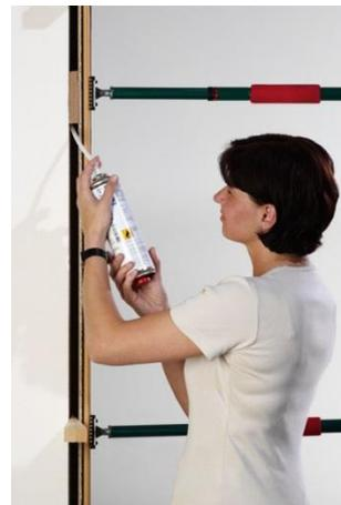
9. Nach Aushärten des Schaumes, Spreizen entfernen und die fertig verleimte Zierbekleidung aufstecken.
