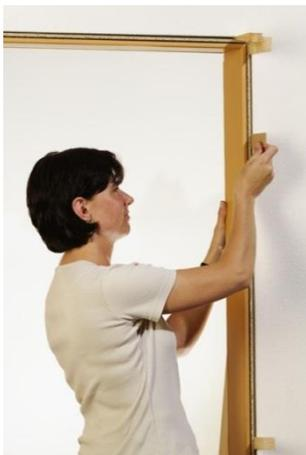
6. Setzen Sie die Spreizen in Höhe der Hinterfüterung.
