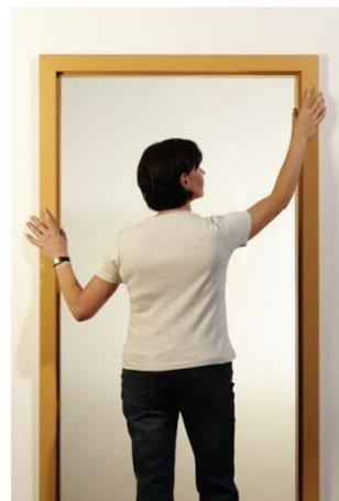
10. Anschließend wird die Zarge nach folgendem Schema (Zeichnung Nr.1), verdeckt vom Falz aus, durch die jeweiligen Aufnahmeelemente, schräg im Mauerwerk verdübelt (Zeichnung Nr.2). Eine Befestigung von einbruchhemmenden Elementen nur mit Montageschaum reicht nicht aus.
