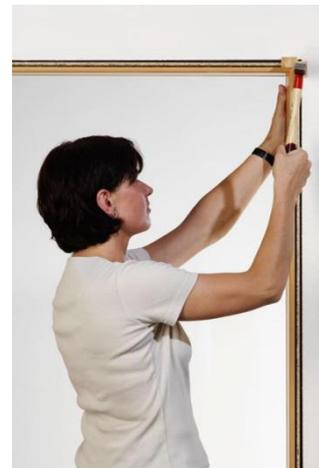
3. Die Waagerechte mit der Wasserwaage überprüfen und ggf. korrigieren.
