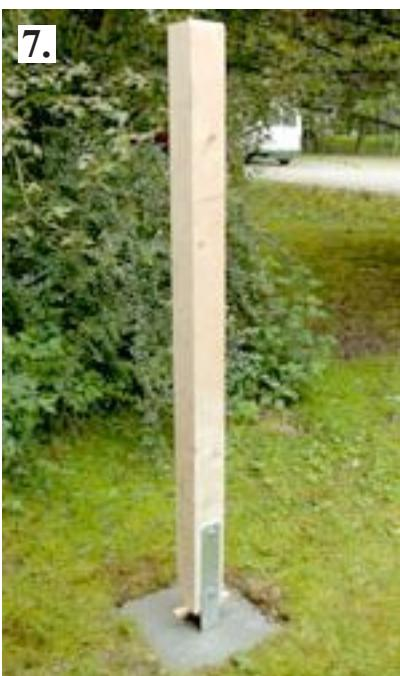
Fertig einbetonierter Pfosten.
