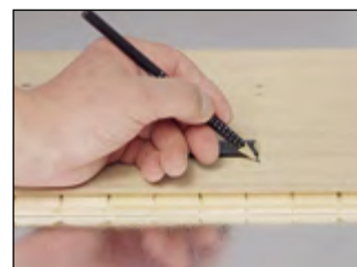
Die letzte Dielle der ersten Reihe wird unter Beachtung des Wandabstands auf die notwendige Länge gekürzt. Das abgeschnittene Stück der Dielle wird als Beginn der zweiten Reihe verwendet.
