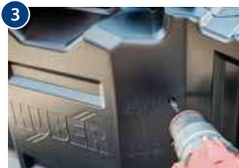
3 Überlaufbohrung setzen (gemäß Ballastierungsvorgabe\*).
