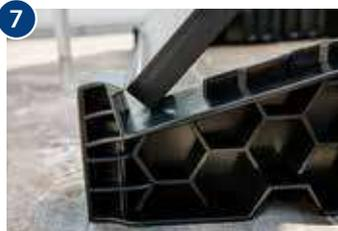
7 PV-Modul in die Adapter-Raster einlegen und einschwenken.
