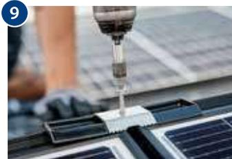
9 PV-Module oben mit der Klemme fixieren. Mit Drehmoment (12 Nm) anziehen.
