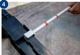
4 Länge des PV-Moduls mit der Montagegange abnehmen und Tank entsprechend positionieren.
