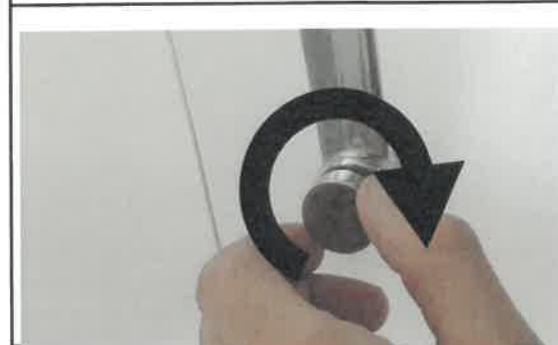
4) Nun Drehen Sie die Abdeckkappe wieder im Uhrzeigersinn auf
