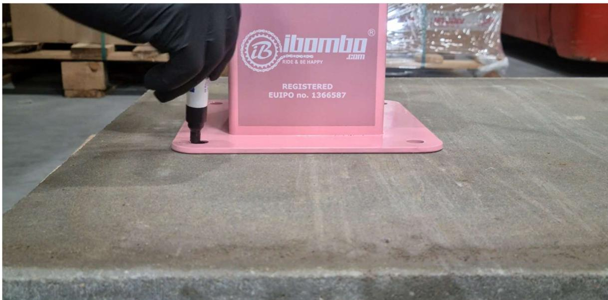
c. Bohren Sie die Löcher mit dem 10 mm - Steinbohrer
