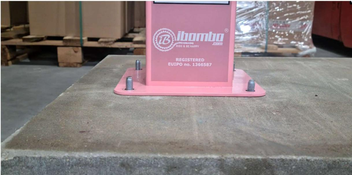
e. Station mit Muttern befestigen und Abdeckkappen aufsetzen.
