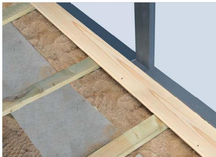
Clouez maintenant les planches avec chaque fois 2 clous B115-040 sur les solives. Autour des planches laissez un espacement de 0,5 cm par rapport aux seuils latéraux et au seuil arrière pour permettre au bois de se dilater. Posez ensuite toutes les autres planches en les assemblant par les languettes et les rainures.
