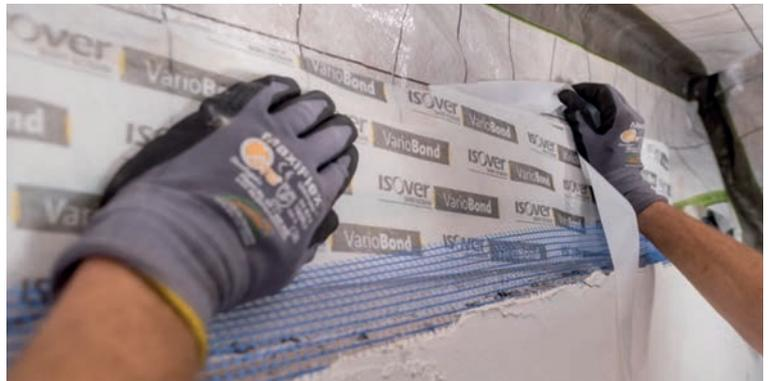
4. Vario® Klimamembran nach oben schieben, um Entlastungsschlaufe zu formen.
