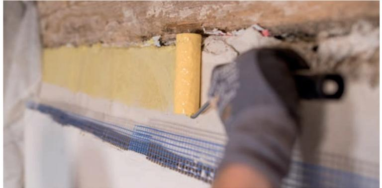
3. Abdeckband (3 cm) von Vario® Bond lösen und auf die Vario® Klimamembran kleben.
