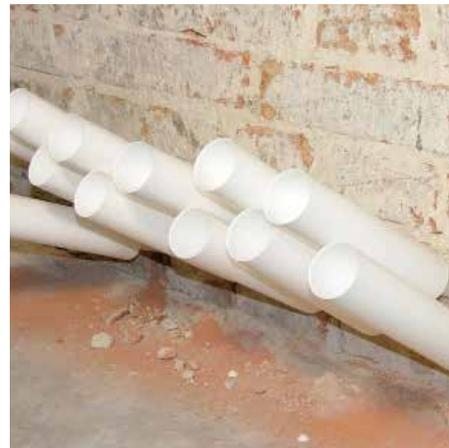
4 Trichter zum Einbringen der Horizontalabdichtung
