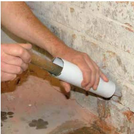
3 Einbringen der Dichtschlämme bzw. Mauer- und Putzmörtel
