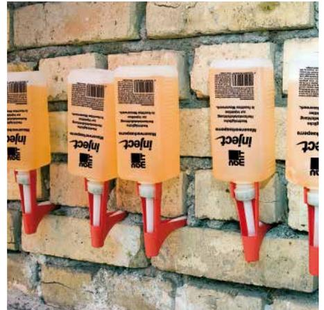
6 Injektionsflüssigkeit dringt in das Mauerwerk
