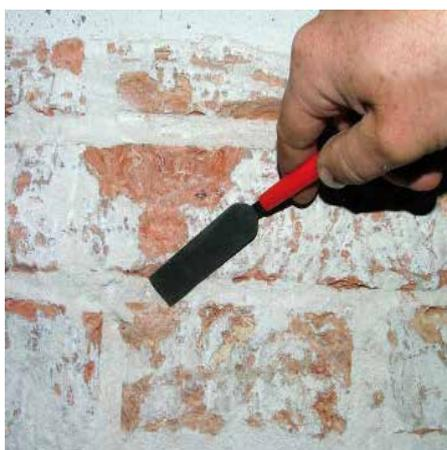
❷ Mürbe Mauerwerksfugen 2 bis 3 cm tief auskratzen, anschließend die Fläche abfeigen oder absaugen; nicht mit Wasser reinigen, da sich so erneut Salze lösen
