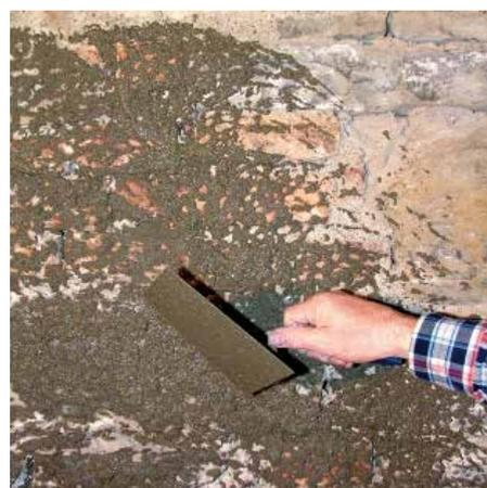
❸ Saniervorspritzmörtel 50 % deckend aufbringen
