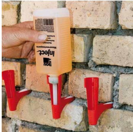
5 Aufsetzen der Bohrloch-Kartusche mit Injektionsflüssigkeit
