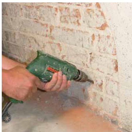
2 Bohrlöcher setzen
