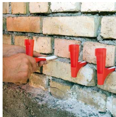
3 Einführen der Kapillarstäbchen und Saugwinkel
