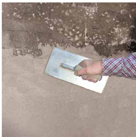
4 Aufziehen des Sanierputzes
