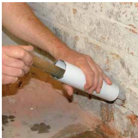
3 Einbringen der Dichtschlämme bzw. Mauer- und Putzmörtel
