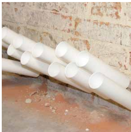
4 Trichter zum Einbringen der Horizontalabdichtung
