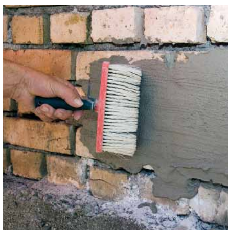
8 Abdichten mit Dichtungsschlämme
