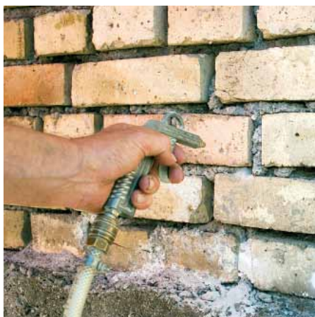
2 Ausblasen der Bohrlöcher
