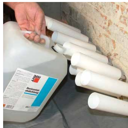
4 Einbringen der Horizontalabdichtung
