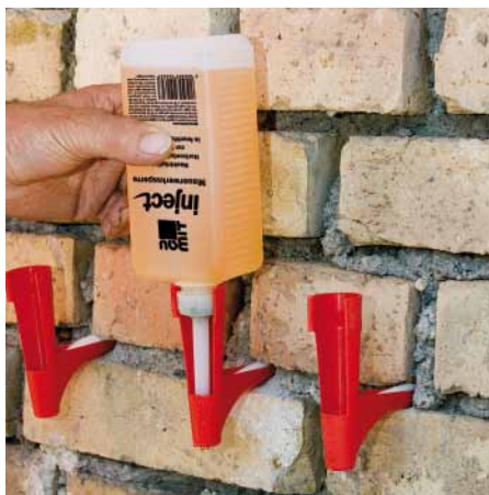
5 Aufsetzen der Bohrlöcher-Kartusche mit Injektionsflüssigkeit
