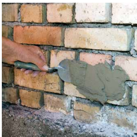
7 Löcher mit Reparaturspachtel verschließen
