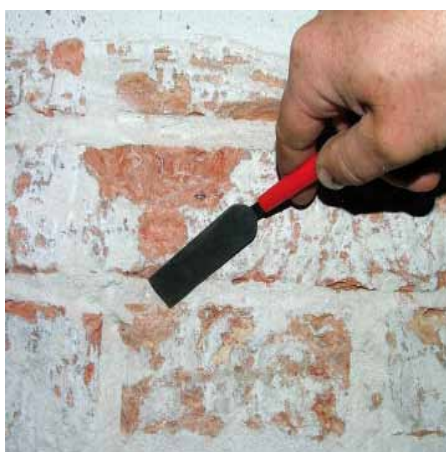
2 Mürbe Mauerwerksfugen 2 bis 3 cm tief auskratzen, anschließend die Fläche abfeilen oder absaugen; nicht mit Wasser reinigen, da sich so erneut Salze lösen
