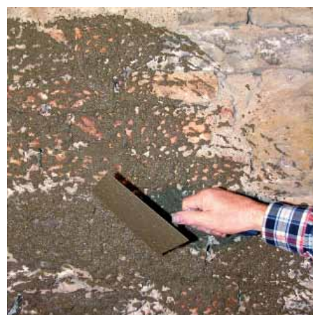
3 Saniervorspritzmörtel 50 % deckend aufbringen
