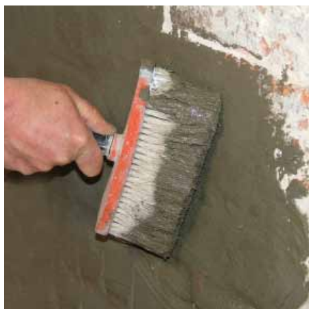
5 Auftragen der Dichtungsschlämme
