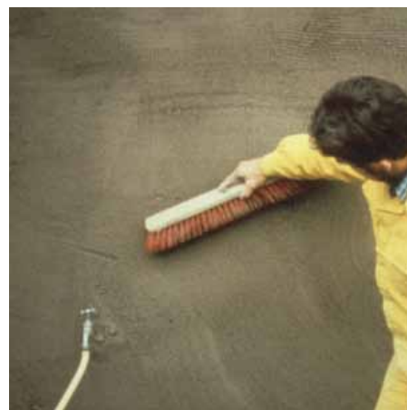
6 Aufrauen der ersten Sanierputzlage
