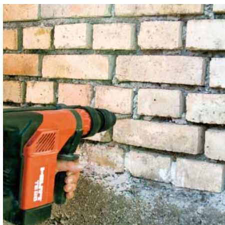
1 Setzen von Bohrlöchern
