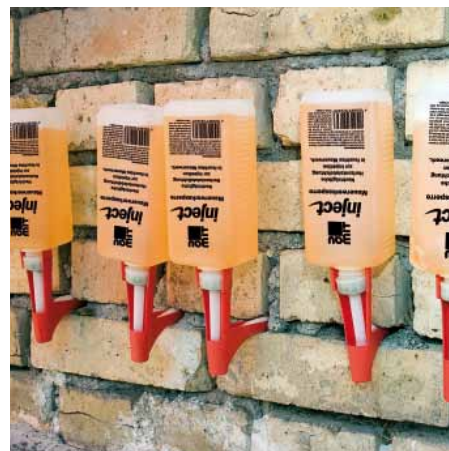
6 Injektionsflüssigkeit dringt in das Mauerwerk
