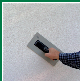
3. Scheibenputz strukturieren
