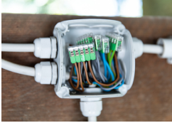
Verdrahtung in der Abzweigdose
