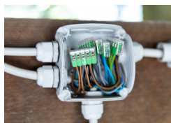
Verdrahtung in der Abzweigdose
