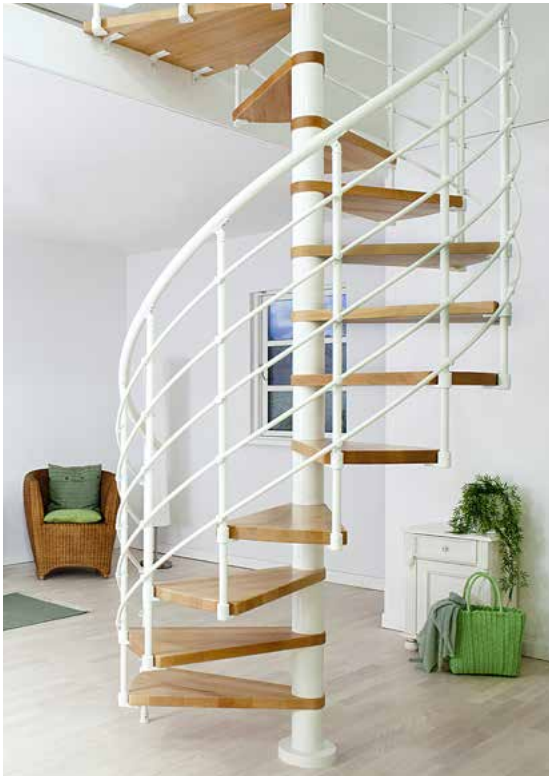
Nebentreppe mit Metallkonstruktion und Holzstufen
