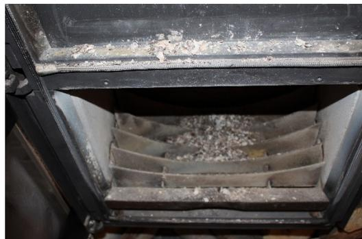
2. Oberen Brennraum von Asche befreien, dazu nutzen wir den xeoos Handschuh und das Twinfire-Rost. 10-15 % der Asche sollten im oberen Brennraum verbleiben. Damit erleichtern wir uns das Anbrennen. Die alte Asche wird nämlich schnell zu einem neuen Glutbett. Der Twinfire Rost sollte immer sauber sein. Vor allem die Löcher müssen frei sein.
