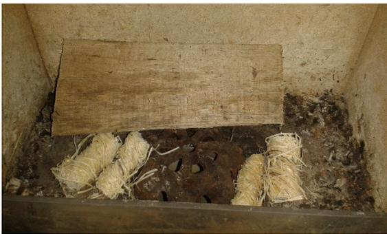
3. Über die Anbrennhilfen von vorne nach hinten Holzspänchen legen. Dann ergibt sich eine kleine „Brücke“. Die Anbrennhilfen anstecken.
