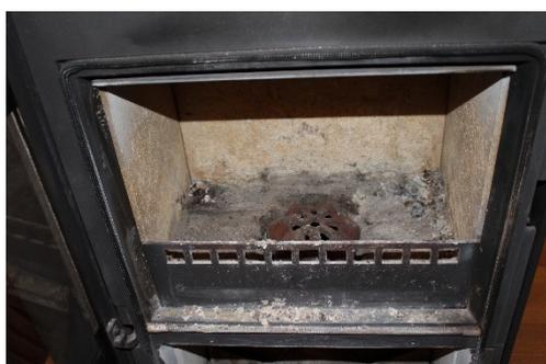
3. Mit einem speziellen Aschestaubsauger kann der Ofen und/oder der Boden vor dem Ofen weiter gereinigt werden. Bitte keine heiße Asche oder gar Glut aufsaugen => Brandgefahr. Die Asche im Aschekasten im unteren Brennraum, am besten mit dem Twinfire Haken, verteilen. Bitte die Asche solange im Aschekasten belassen, bis dieser voll ist. Die Asche ist dabei wertvoller zusätzlicher Energiespender im Twinfire Betrieb. Den Aschekasten als erst dann leeren, wenn er komplett voll ist.
