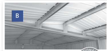
Verbindungsstelle zweier zusammengebauter Gerätehäuser „Europa“
